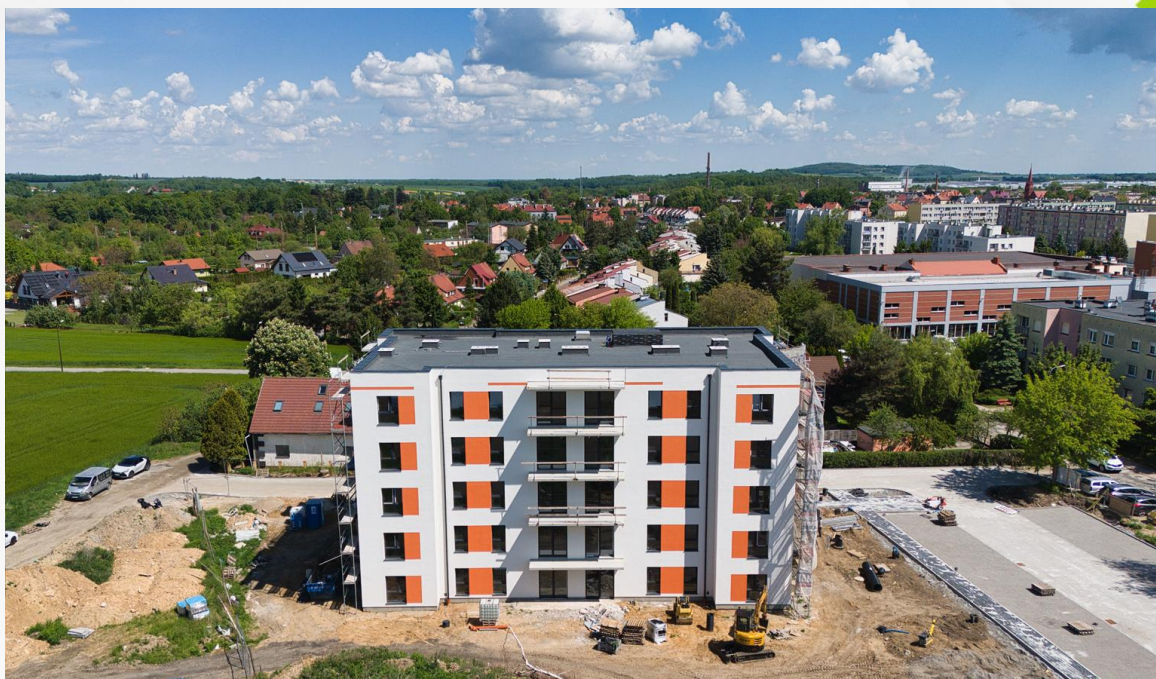
Ilustracja 7: Realizacja budowy SIM Sudety
