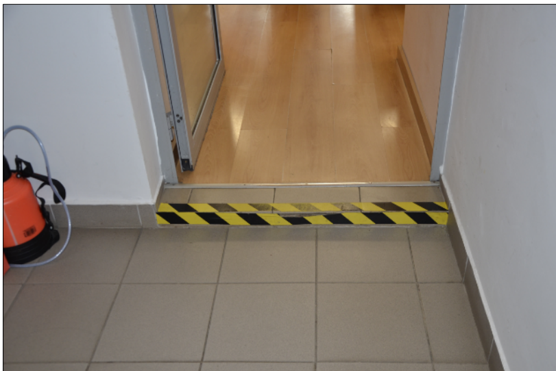
Ilustracja 42: Przejście z budynku „C” do budynku „B”
