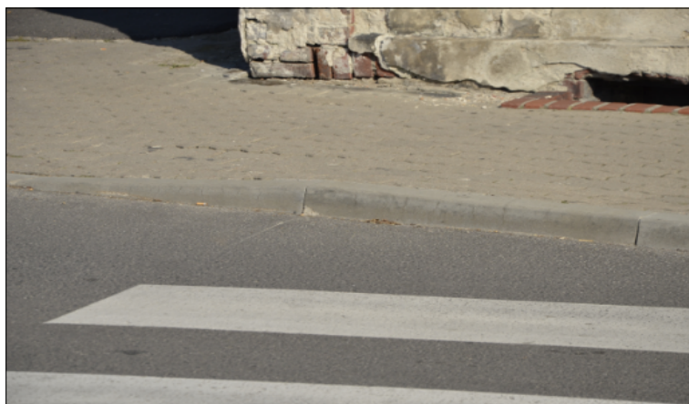
Ilustracja 14: Przejście dla pieszych (jw.)
