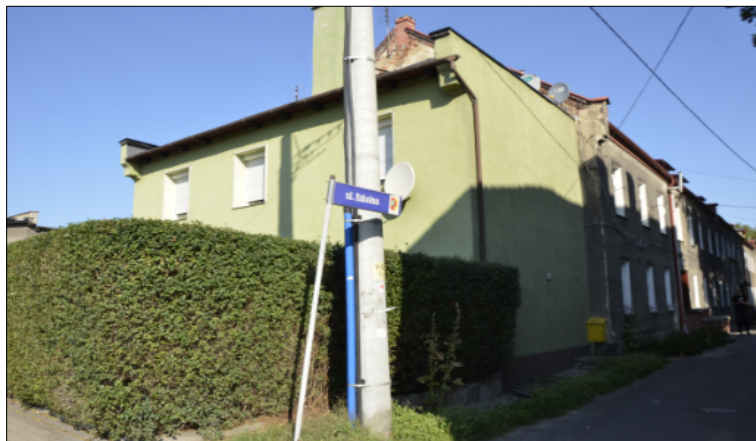
Ilustracja 15: Przejście dla pieszych (jw.) – brak kierunkowskazu do Urzędu Miejskiego
