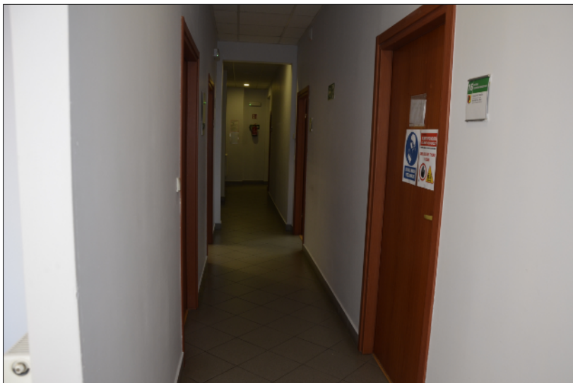
Ilustracja 46: Korytarz na I piętrze budynku „D”:
