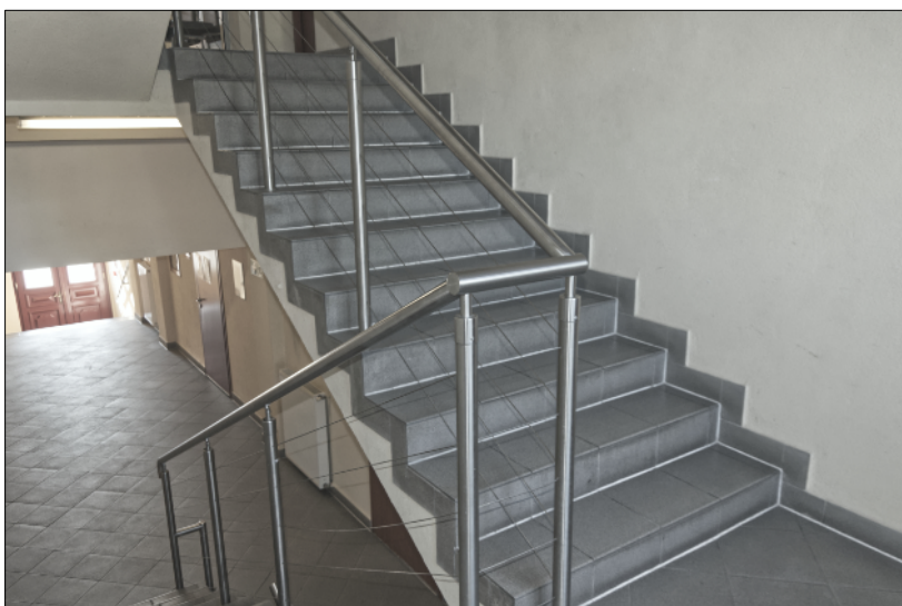
Ilustracja 26: Schody wewnątrz budynku
