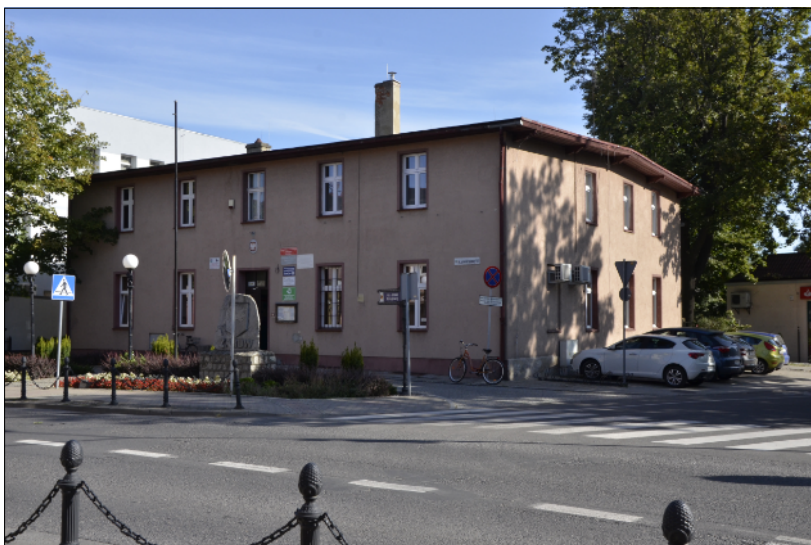
Ilustracja 48: Budynek przy ul. Armii Krajowej 54
