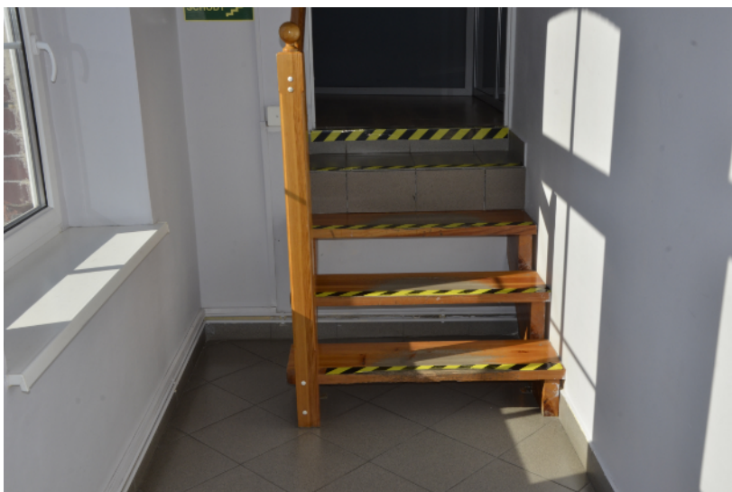
Ilustracja 47: Schody łączące I piętro Budynku „D” i budynku „A”
