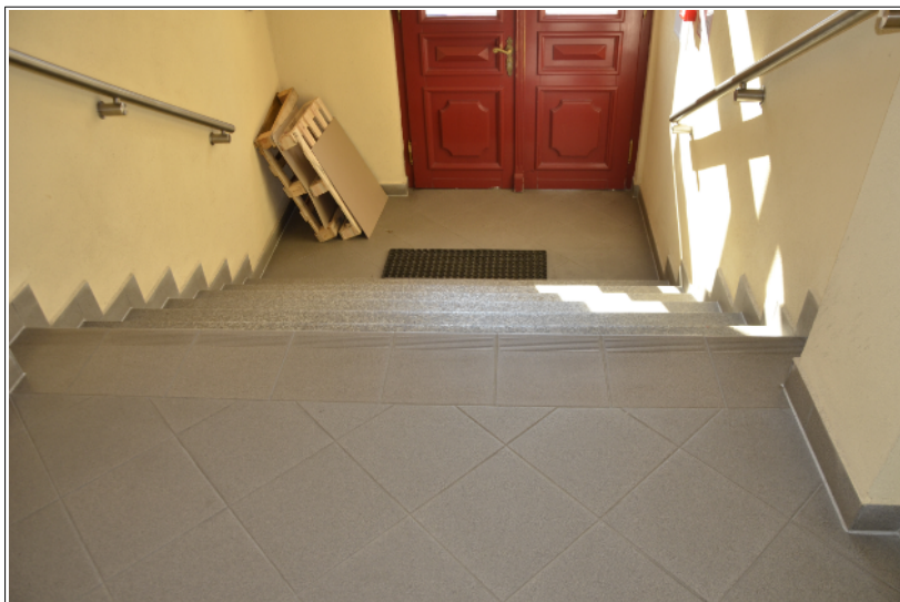
Ilustracja 22: Za wejściem głównym (A1) znajdują się kamienne schody prowadzące z poziomu chodnika na pierwszy poziom budynku.
