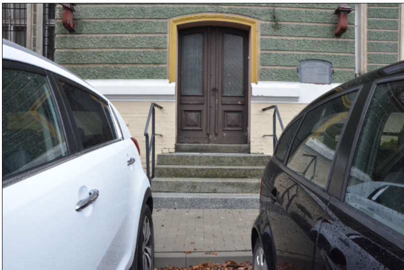
Ilustracja 23: Wejście (A2) do budynku od strony parkingu – Wyjście awaryjne:
