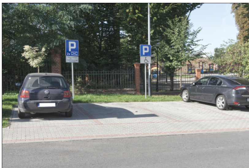
Ilustracja 19: Miejsce parkingowe dla osób niepełnosprawnych – niewłaściwe rozmiary i niezgodne z przepisami oznaczenie miejsca parkingowego
