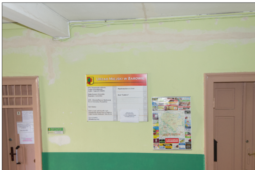
Ilustracja 50: Tablica informacyjna (korytarz na parterze budynku):
