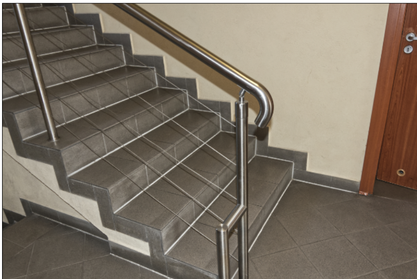
Ilustracja 25: Na wyższe poziomy budynku prowadzą schody:
