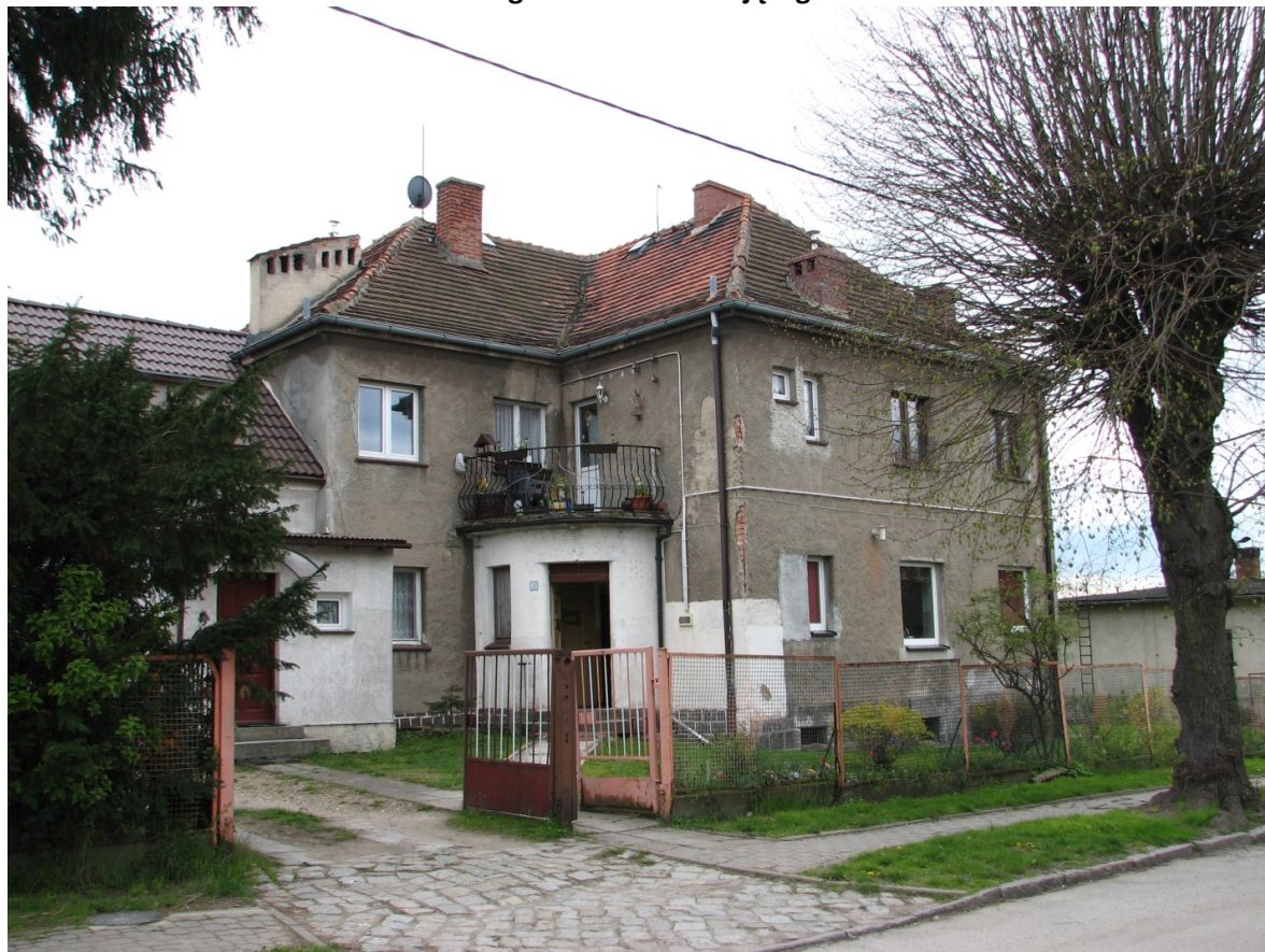
Fotografia stanu istniejącego
